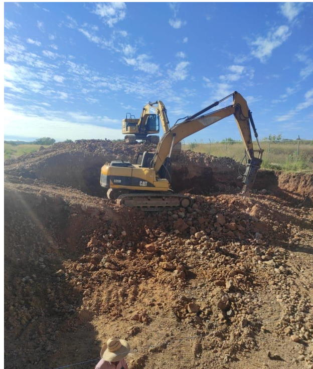
EXCAVACION DE CRIPTAS
