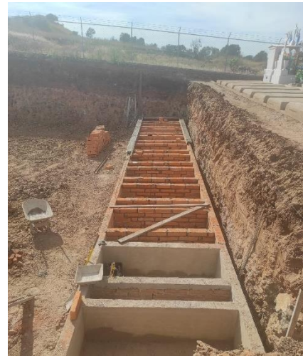
CONSTRUCCION DE CRIPTAS
