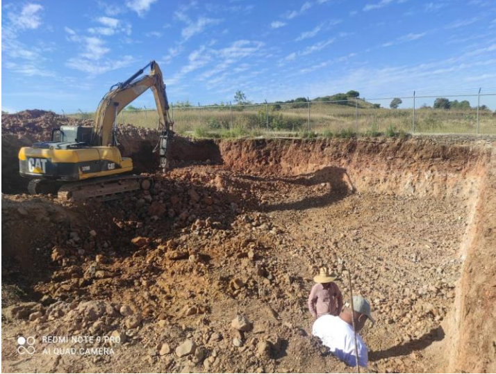
EXCAVACION DE CRIPTAS
