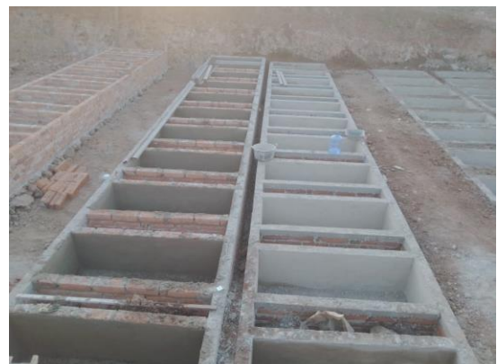
CONSTRUCCION DE CRIPTAS
