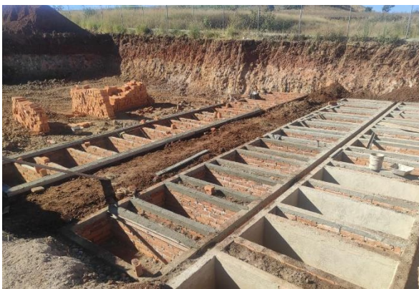
CONSTRUCCION DE CRIPTAS
