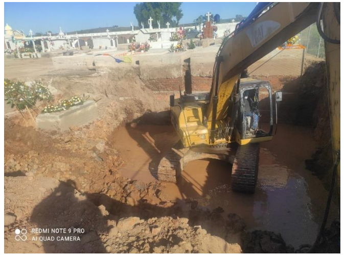
EXCAVACION DE CRIPTAS
