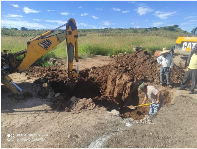
EXCAVACION DE CRIPTAS
