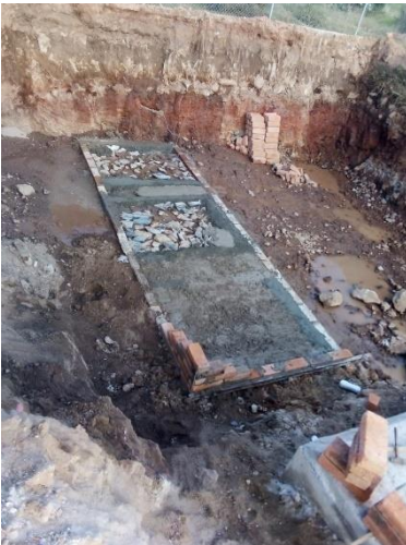
CONSTRUCCION DE CRIPTAS
